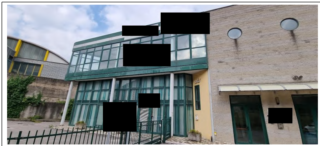
Vista sud-est - facciata sala esposizione PIANO PRIMO
